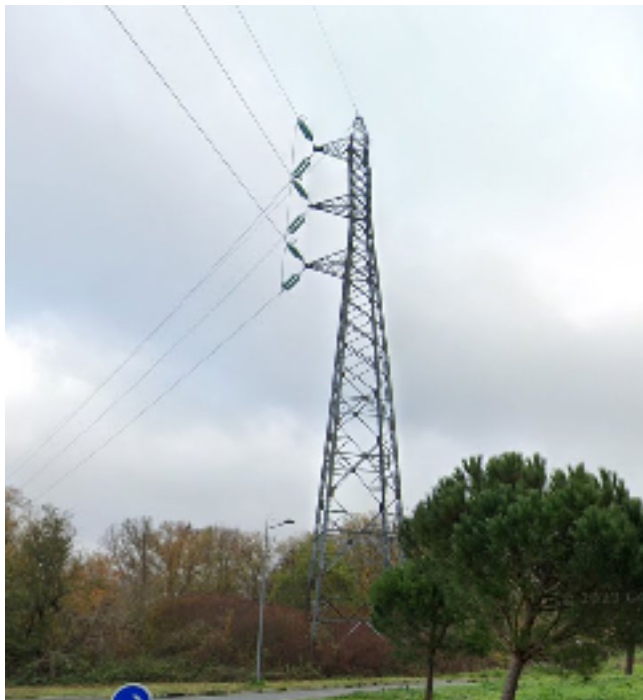
Figure 26 - Pylône avec une seule liaison
